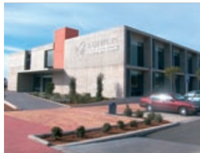
Edificio espaitec 1, concebido como incubadora de empresas.
