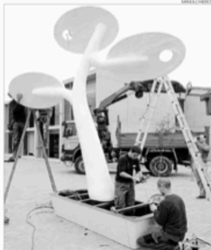
Los técnicos montaban ayer delante del EspaiTec el primer árbol.
